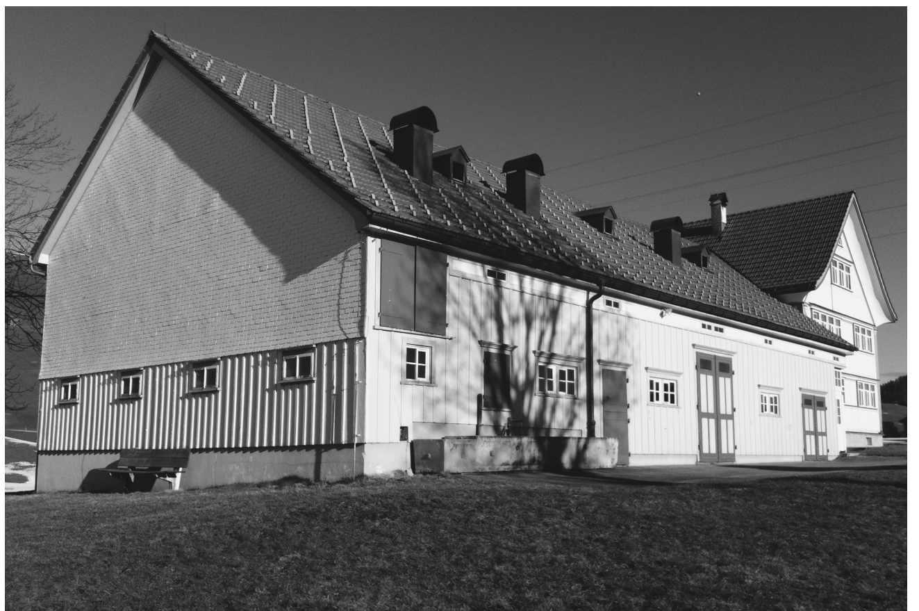
Die Liegenschaft «Fochsjockelis» vor dem Stallumbau.
