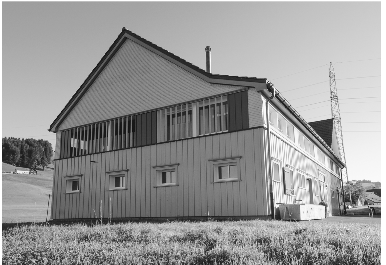
Hinter den Staketten links verbirgt sich eine offene, unbeheizte Loggia.
